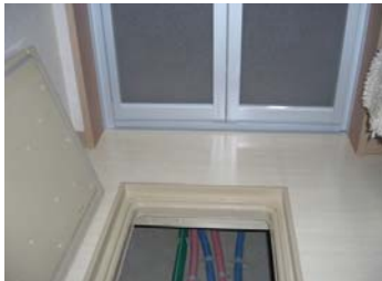
①ベタ基礎床下
