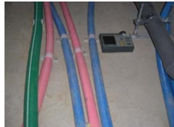
①ベタ基礎測定器設置
